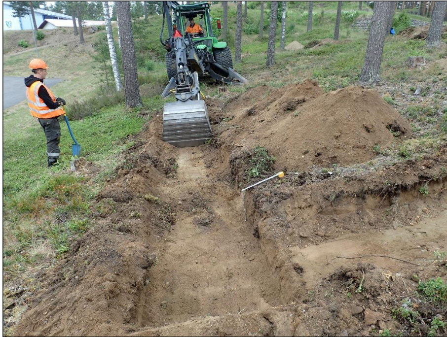
Koira-aitauksen lounaiskulman kaivua. Pohjoiseen.
